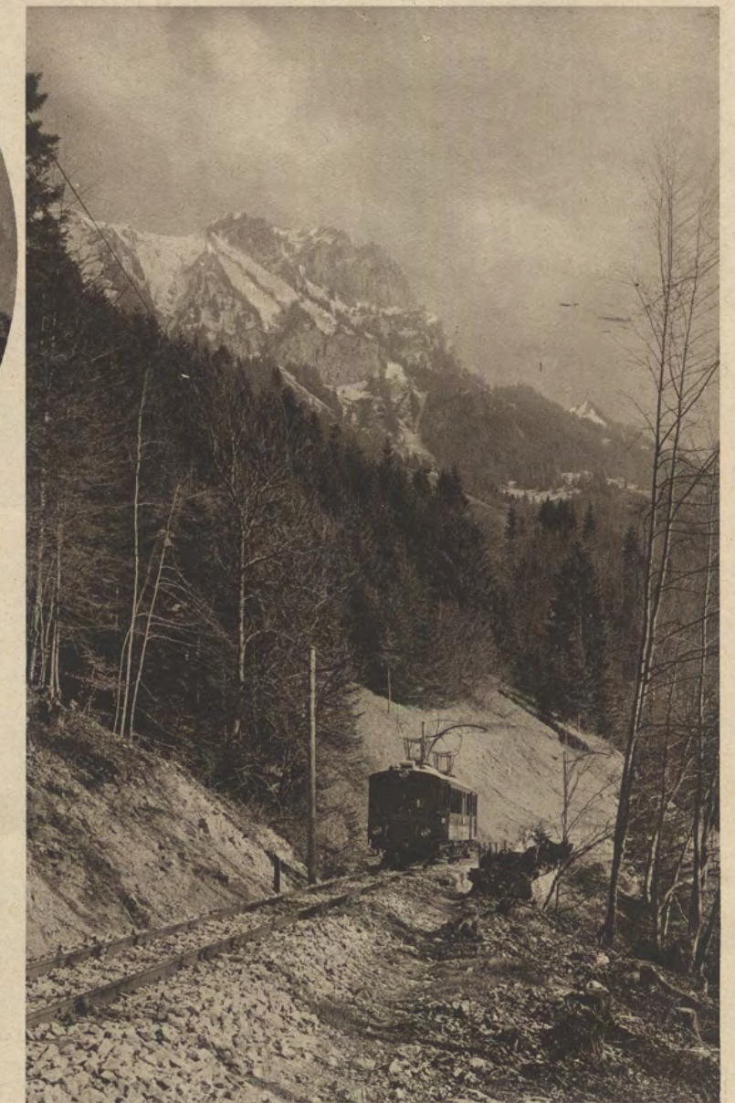
Vue de la ligne Aigle-Sépey-Diablerets et des Chamossalres.
