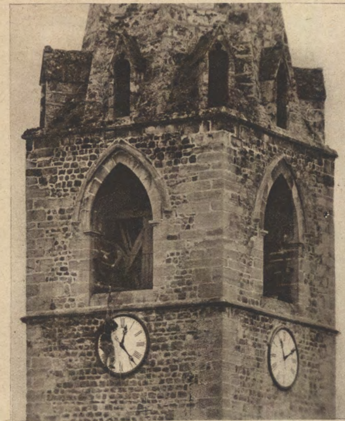
Comment on répare un cadran. Cette curieuse photographie a été prise au cours des réparations récentes faites au cadran de l'horloge du Clocher de Bex.
