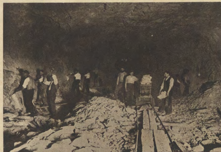
Grande salle du Coulat. Extraction de la roche salée.
