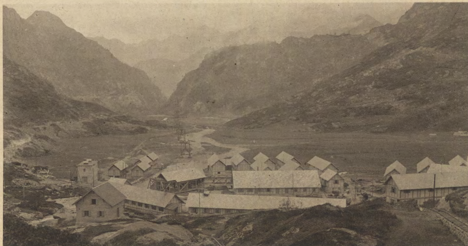
A Barberine, les Chemins de Fer fédéraux ont fait entreprendre d'importants travaux. Il s'agit de la construction d'un barrage qui retiendra un immense lac artificiel servant de réservoir pour une usine électrique dans la plaine.
