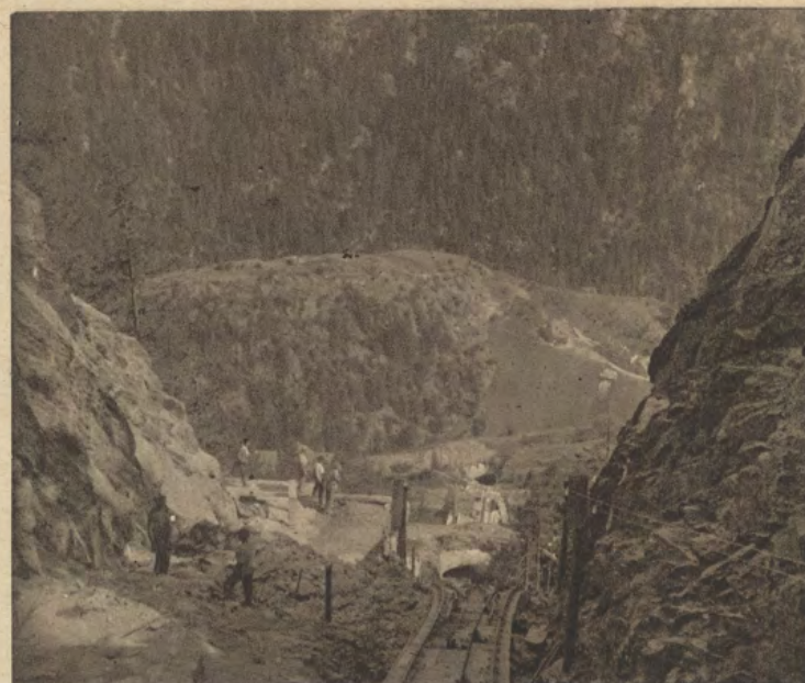
A Barberine, les Chemins de Fer fédéraux ont fait entreprendre d'importants travaux. Il s'agit de la construction d'un barrage qui retiendra un immense lac artificiel servant de réservoir pour une usine électrique dans la plaine.
