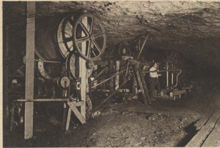
Mines du Bouillet. Ascenseur et moteur de la Pompe Durozol à veines liquides élevant l'eau salée à 100 m. de haut.
